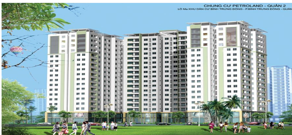
Công trình Chung cư Petroland - quận 2, TP Hồ Chí Minh
