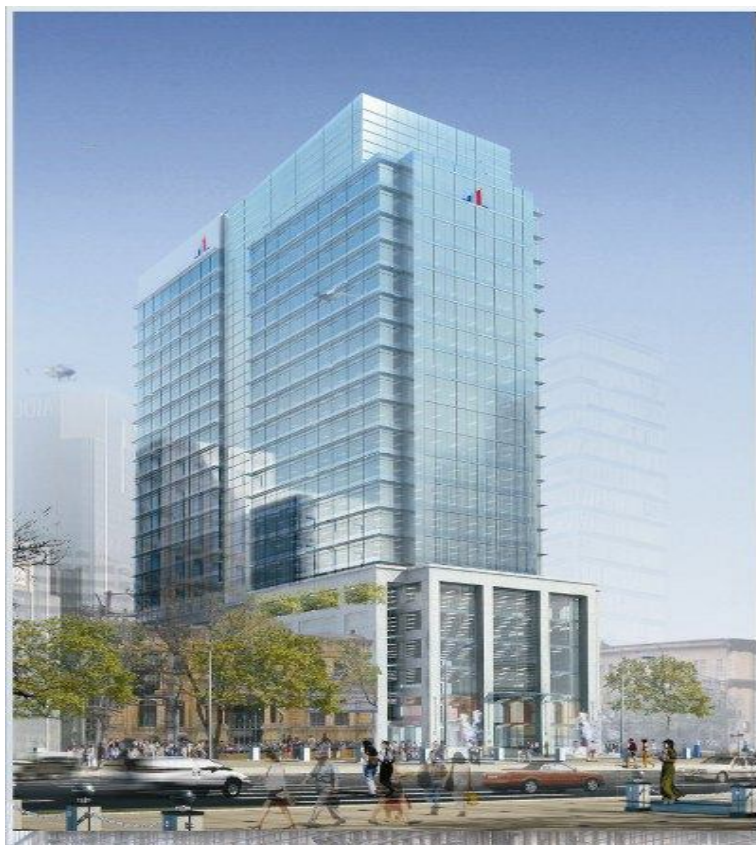
Công trình HaNoi Capital – Trần Hưng Đạo, Hà Nội
